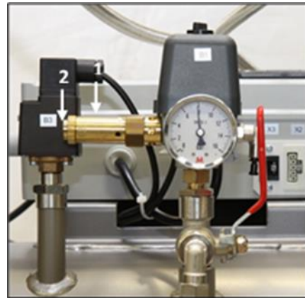
Fig. 17: Contrôle de la soupape de sécurité
