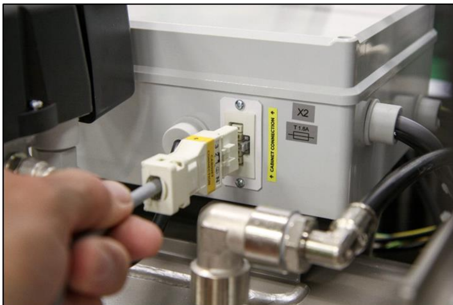
Fig. 13: Raccordement de l'armoire au compresseur
