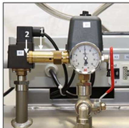
Obr. 17: Kontrola pojistného ventilu
