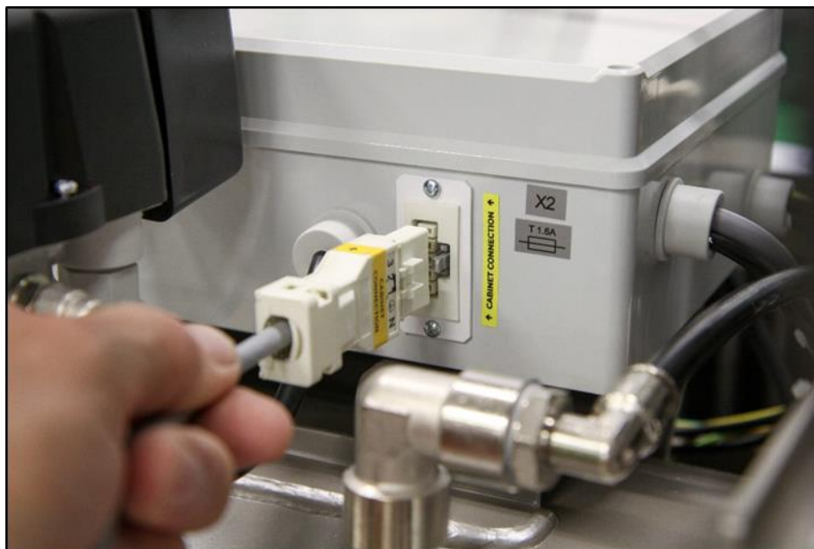
Рис. 13: Подключение шкафа к компрессору
