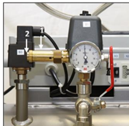
Obr. 17: Kontrola poistného ventilu
