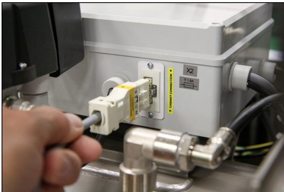
Rys. 13: Podłączanie obudowy do sprężarki
