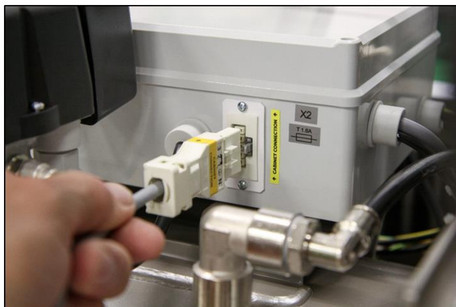
Rys. 13: Podłączanie obudowy do sprężarki
