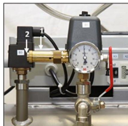
Obr. 25: Kontrola pojistného ventilu
