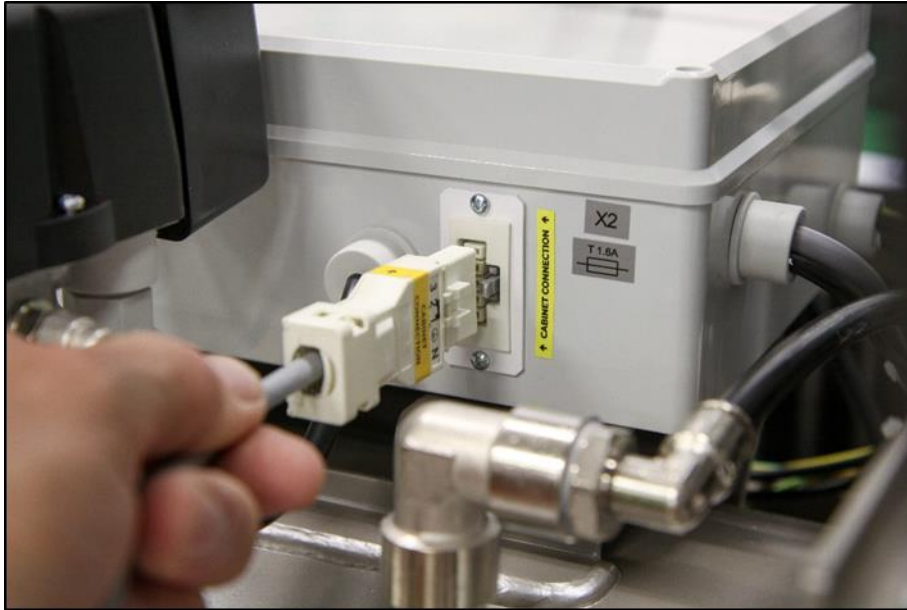
Рис. 13: Подключение шкафа к компрессору
