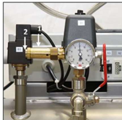
Obr. 25: Kontrola poistného ventilu
