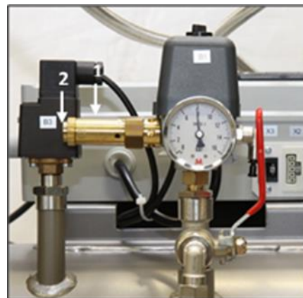
Fig. 25: Contrôle de la soupape de sécurité
